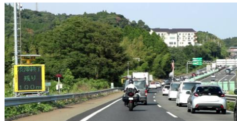
図-9 対策後の現地写真(79.5kp付近)
